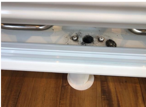
⑤排水口・目皿についた汚れをお掃除 ※結露水が漏水する恐れがあります。
